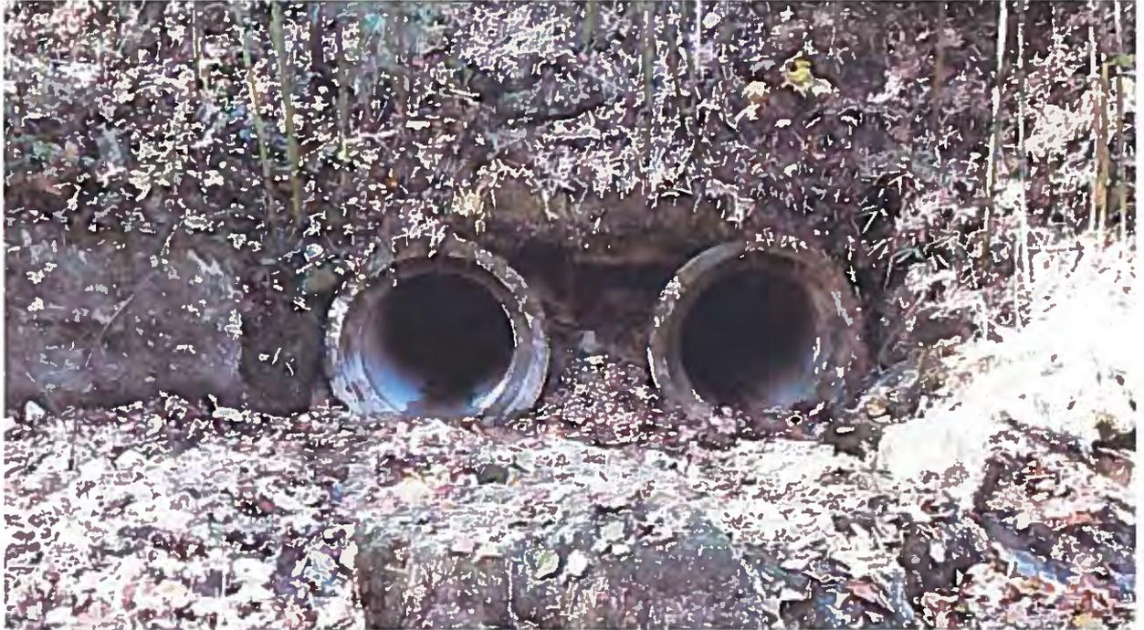
*Figura 5.44 – Condotte di attraversamento all'imbocco*
