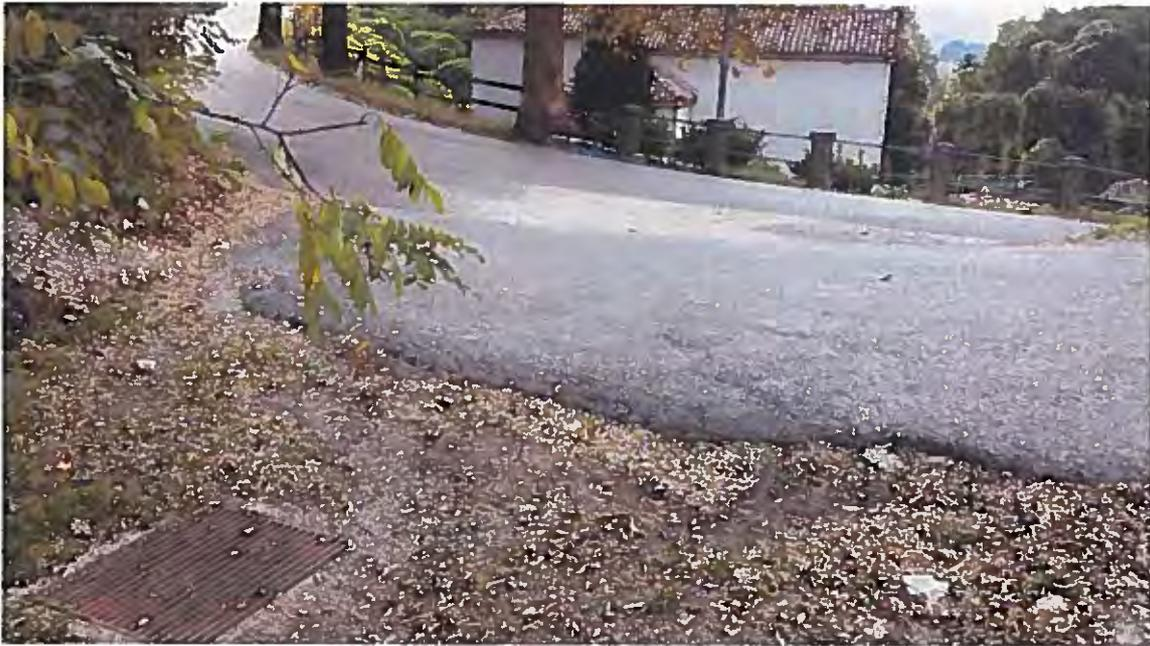
*Figura 5.2 – Captazione acque provenienti da monte tramite tombino a raso*
